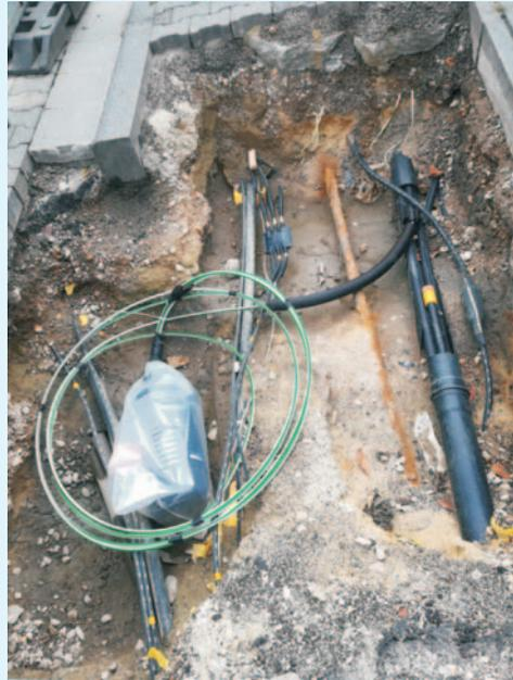
Die Hauptwasserleitung wurde neu verlegt, die Hausanschlüsse (Gas, Wasser, Strom, Telekom) erneuert, und die Arbeiten aller Versorger an Ihren Netzen wurden im 1. Bauabschnitt erledigt.
