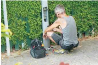
die alten, stromfressenden Lampenköpfe der Straßenleuchten sind gegen hochmoderne LED-Leuchten (LED = Light Emitting Diode) ausgetauscht worden.
