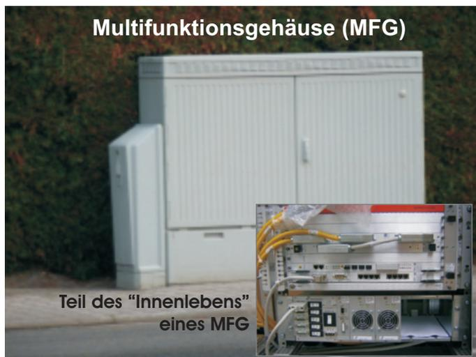
Der nächste Schritt ist, dass die Telekom die sog. aktive Technik einbaut. Dies sind die Bauteile, die eine Verteilung und Schaltung von VDSL Vectoring erst möglich machen.
